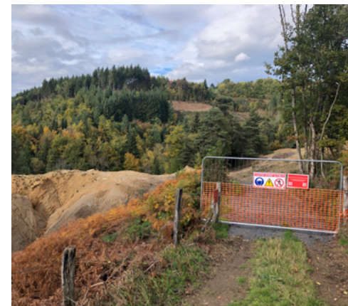
Chantier de réhabilitation de l'ancien terril © Parc Livradois-Forez
