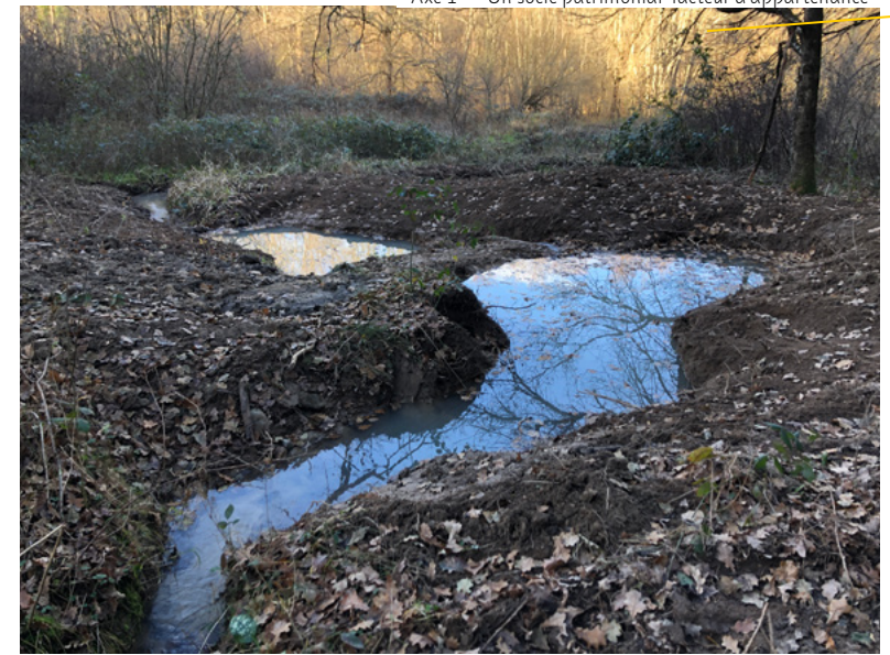
Bassin de décantation - cavité minière © Parc Livradois-Forez
