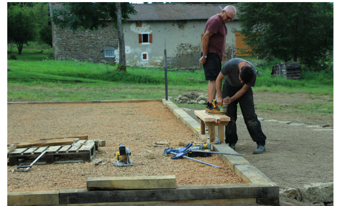
Chantier du Jardin de la Clémentine © Louis Simonin
