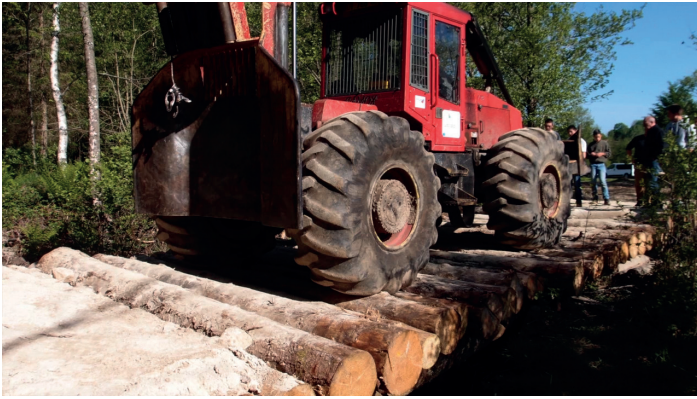
Exemple d'ouvrage de franchissement de cours d'eau pour l'exploitation forestière © Jean-Pierre FOURNIOUX
