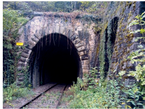
Tunnel d'Archimbaud © DR
