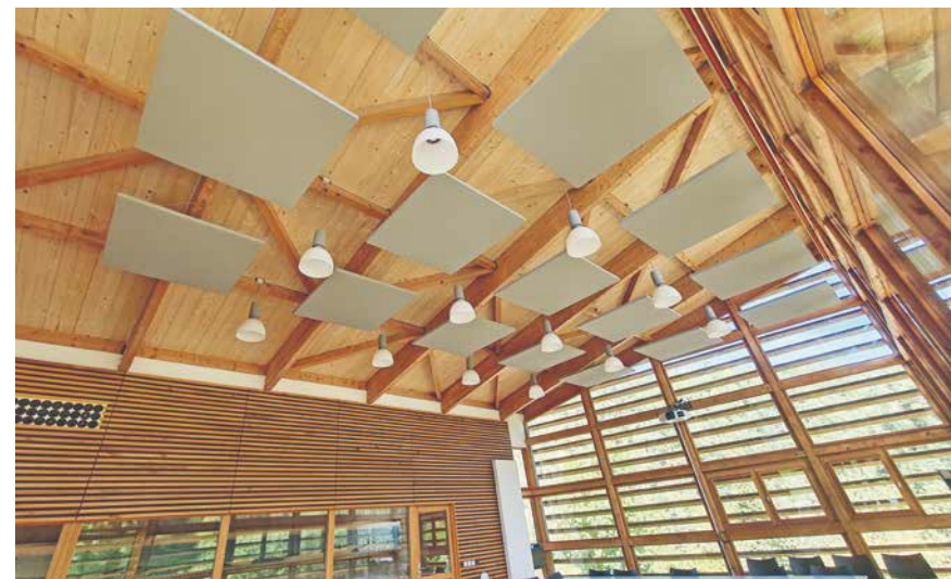
Toiture de l'atelier haut de la Maison du Parc à Saint-Gervais-sous-Meymont (63), Bruhat & Bouchaudy
