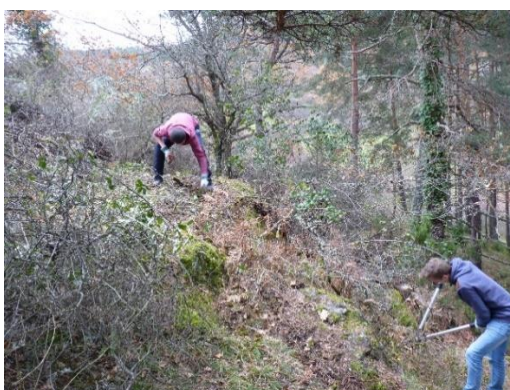
Photo 12 – Dégagement des rochers de serpentinite
