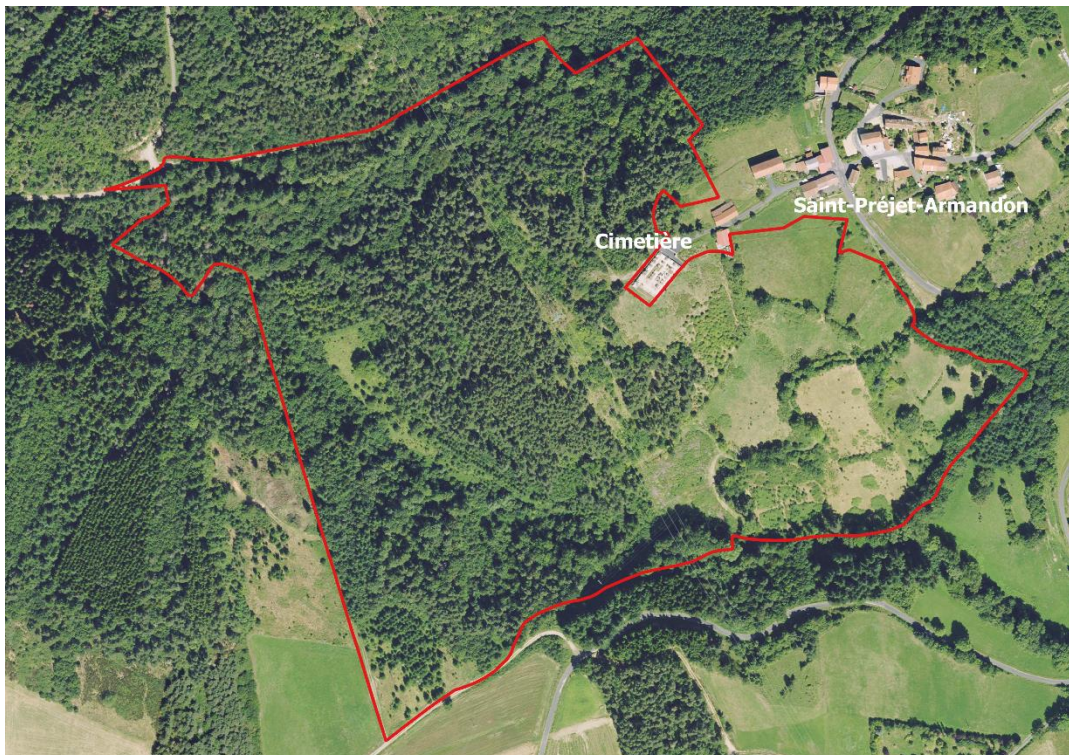
Figure 3 – Vue aérienne du site (Source : IGN)
