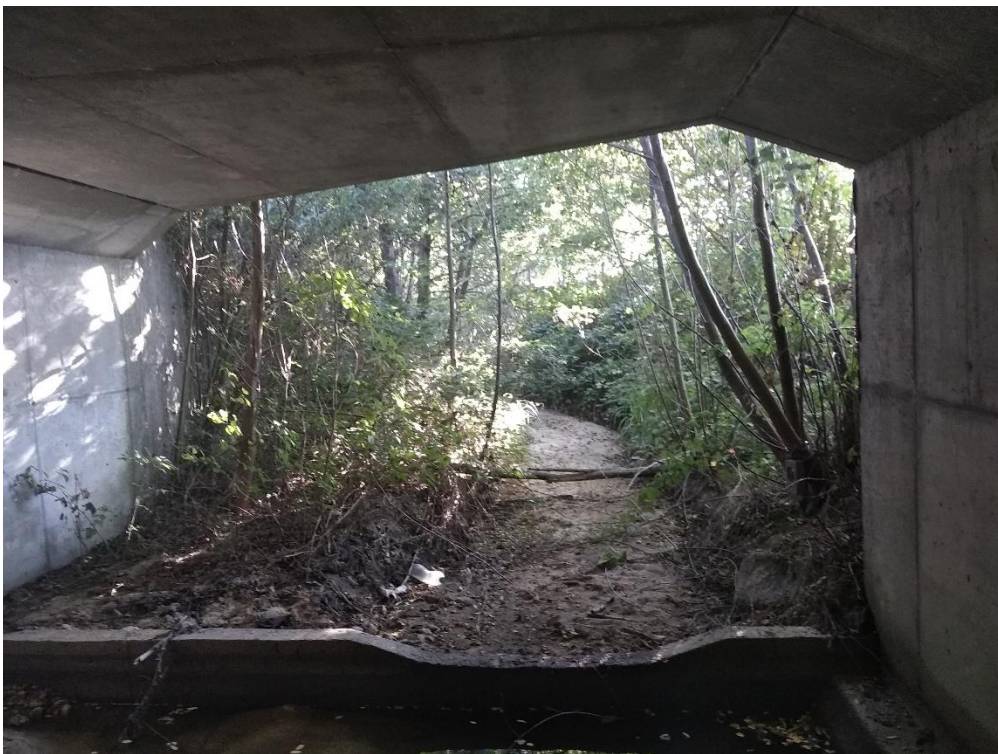
Figure 11 : Ouvrage H - Pont de la D906 sur le ruisseau de Reynord
