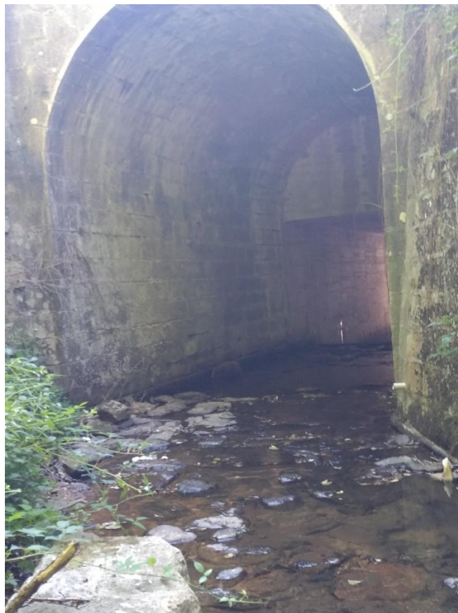
Figure 8 : Ouvrage E – Pont sur le ruisseau de la Penderie avant de rejoindre La Dore
