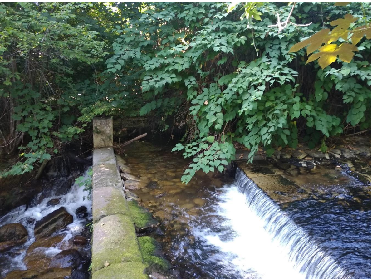
Figure 6 : Ouvrage C - Pont sur le Vertolaye avant de se jeter dans La Dore
