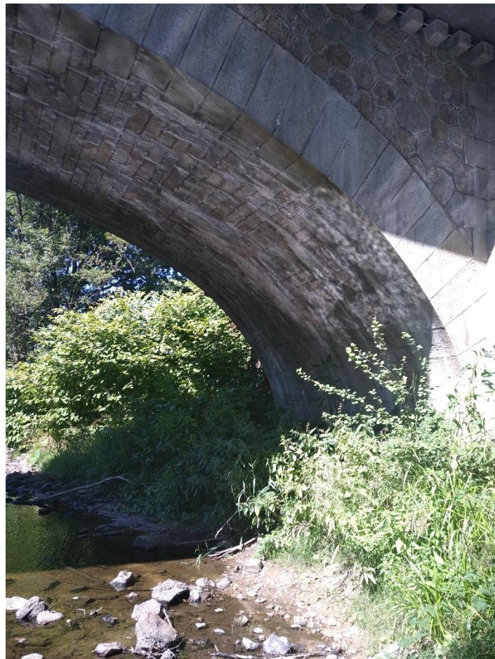
Figure 4 : Ouvrage A - Pont sur la Dore en amont de Vertolaye
