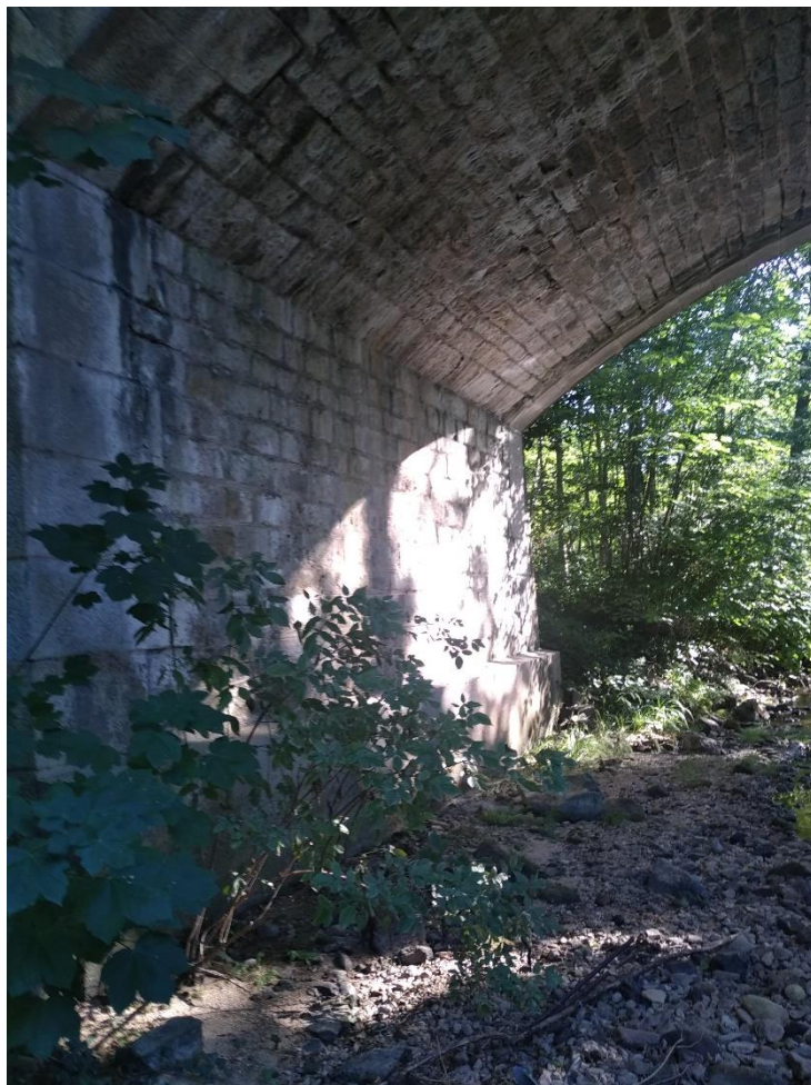
Figure 10 : Ouvrage G - Pont sur la Faye avant de rejoindre La Dore
