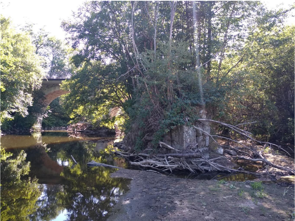
Figure 7 : Ouvrage D - Pont de David sur la Dore
