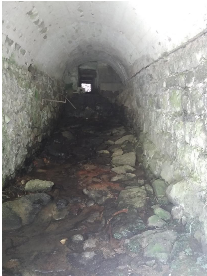
Figure 5 : Ouvrage B – Pont sur un affluent de la Dore
