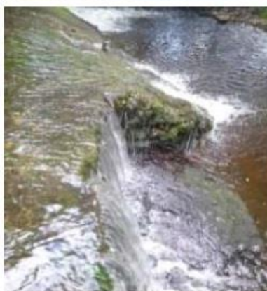
Parement aval en partie centrale de l'ouvrage
