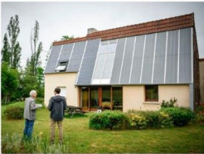
association Toi & Tots, panneaux solaires
