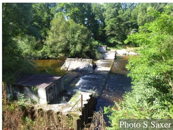
L'ouvrage n'est pas en mauvais état. Il est constitué de massifs bétonnés ancrés en amont et en aval dans des rideaux de palplanches métalliques.
