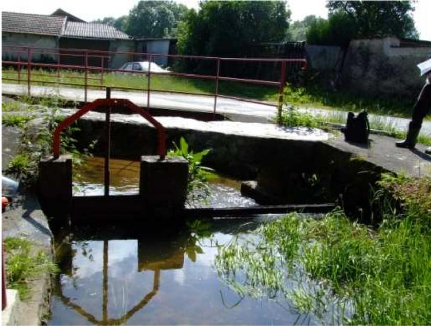
Photo 10 : Seuil avec une vanne levante sur le ruisseau du Riolet (Source : J. CADEL, 2010)
