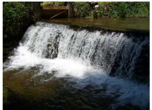
Les seuils à paroi verticale (photo 6) ou inclinée (photo 7) contiennent les eaux qui s'écoulent par surverse sur une crête dont la largeur peut être plus étroite que la hauteur de chute
