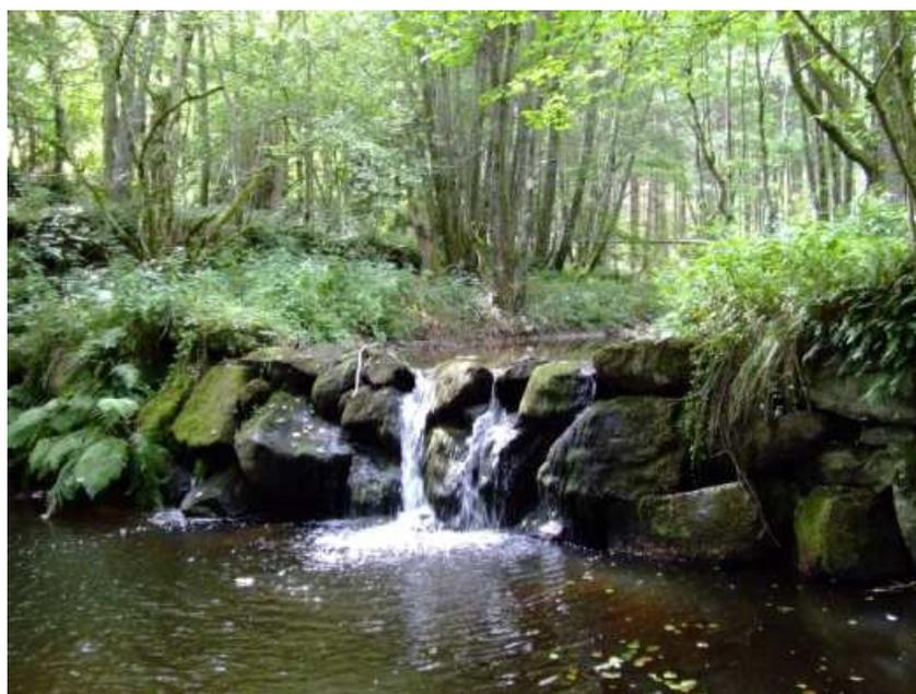
Photo 8 : Seuil en enrochements sur le ruisseau des Escures (Source : J. CADEL, 2010)
