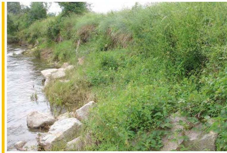
**Photos 18 et 19 :** Démantèlement en cours de l'enrochement de rive gauche installé au début des années 1990 en amont immédiat de l'ancienne sablière de Garmy (commune de Dorat)
