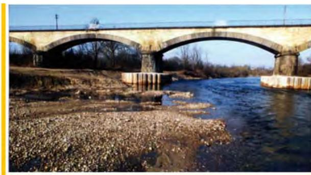
**Photo 8 :** Le viaduc SNCF de Courty à la fin des travaux de renforcement de ses piles en 1992
