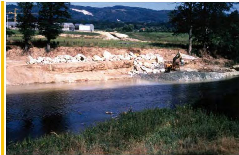
**Photo 17 :** Pose de l'enrochement en rive droite de la Dore, en amont immédiat du pont de la D. 906, juillet 1990
