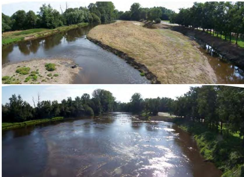
**Photo 15 :** Le banc de graviers en amont du pont de la D 63 sur la Dore à Puy-Guillaume, en 2006 avant et après son enlèvement
