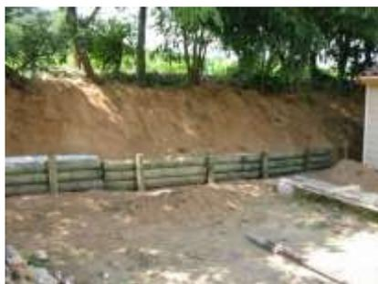
Il sera possible de maintenir les talus créés tout autour par un système de fascines en branchage ou en utilisant des poteaux téléphoniques tel qu'on en trouve déjà sur le site.
