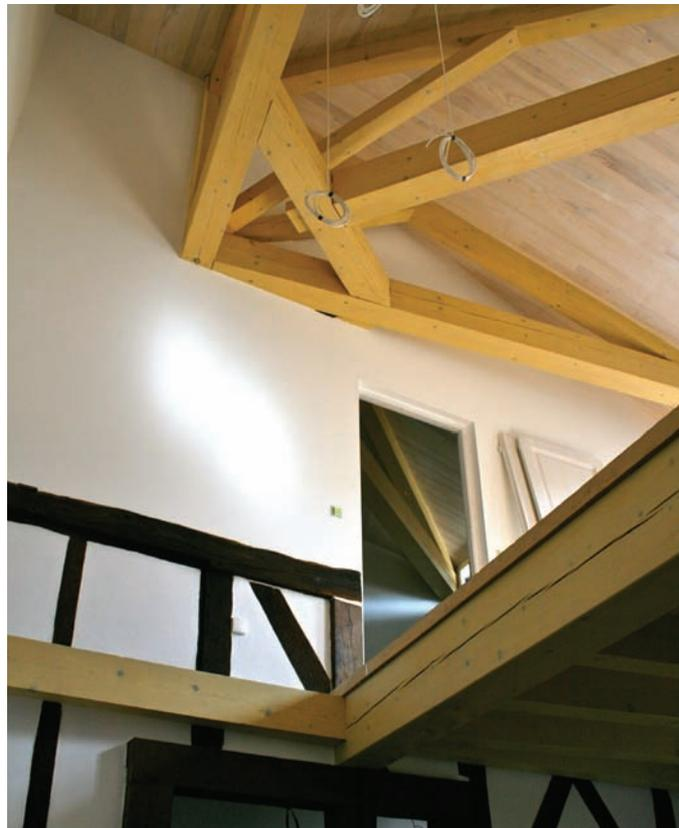
*Rénovation rue de la boucherie, valorisation d'un pan de mur à colombage, et d'une charpente, par la création d'une pièce double hauteur sous toiture*
