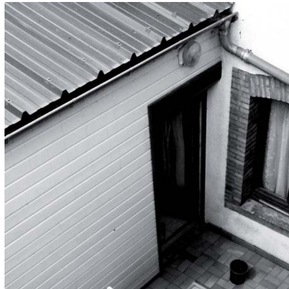
16-446. Façade isolée par l'extérieur, bardage PVC.
