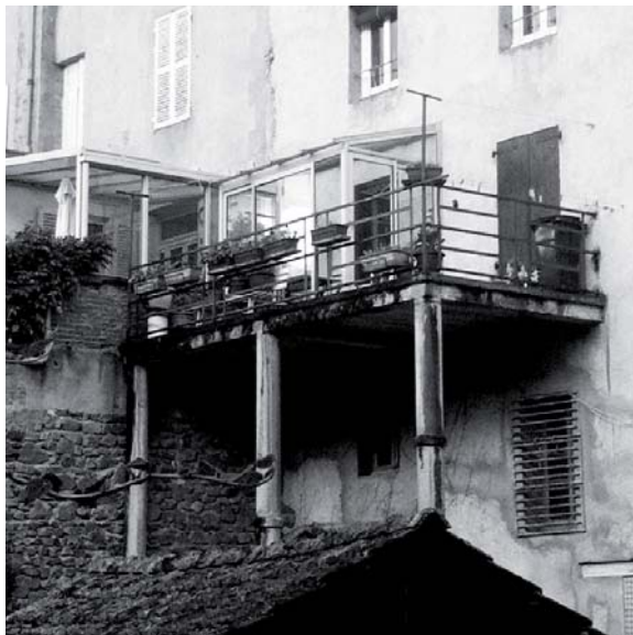
16-445. Terrasse en béton sur poteaux.
