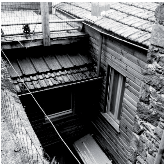
16-442. Façade isolée par l'extérieur, bardage bois.
