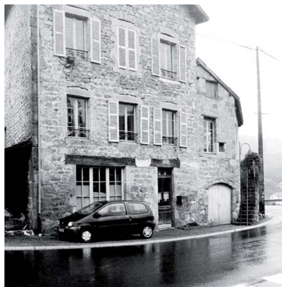
16-454. Dans le retrait de la façade sur la rue, sur le seuil du logement.
