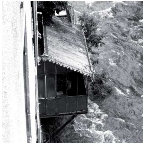
16-447. Abri en acier en avancée sur la Dore.
