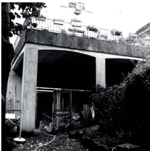
16-440. Terrasse en béton avec abri inférieur.
