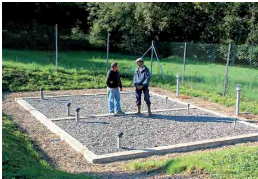
Station d'épuration de Saint-Gervais-sous-Meymont
