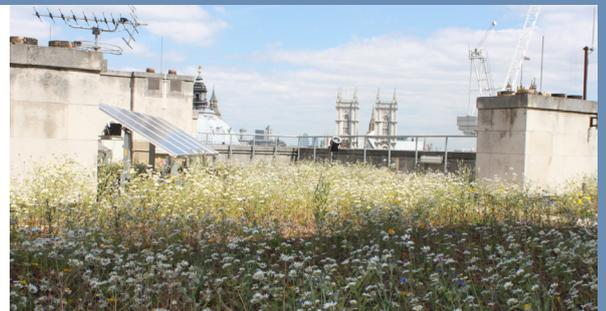
Sur la skyline de Victoria et Westminster à Londres a été installé un toit végétalisé spécifiquement conçu dans le but d'accueillir des invertébrés rares. La toiture est composée de deux épaisseurs de substrat différentes ainsi que de petits monticules de sable grossier afin de favo-
