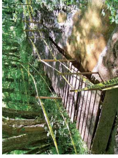
Dispositifs provisoires de franchissement
