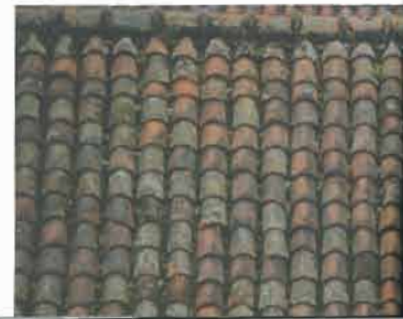
Toiture en tuiles canal traditionnelles
