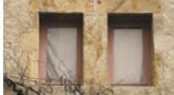
En réhabilitation il est préférable d'éviter les ouvertures horizontales d'un seul tenant, souvent incompatibles avec la composition des façades. Jumeler deux fenêtres verticales classiques offre une surface vitrée analogue et facilite l'intégration dans une façade existante.
