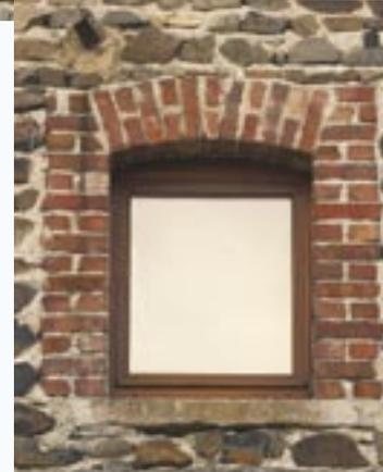
La brique est utilisée pour l'encadrement des ouvertures.
