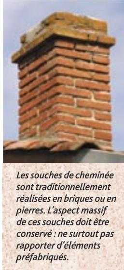
Les souches de cheminée sont traditionnellement réalisées en briques ou en pierres. L'aspect massif de ces souches doit être conservé : ne surtout pas rapporter d'éléments préfabriqués.
