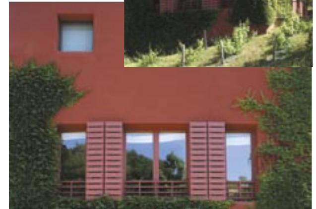
*L'impact visuel de la vaste ouverture du pignon ouest est largement atténué par un système de protection en bois faisant office de brise soleil, directement inspiré des parois ventilées des séchoirs de Limagne.*
