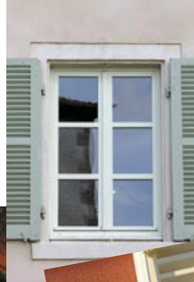
Les encadrements existants sont soulignés ici par un léger relief en creux de l'enduit et par une teinte qui tranche avec celle de l'enduit de façade.
