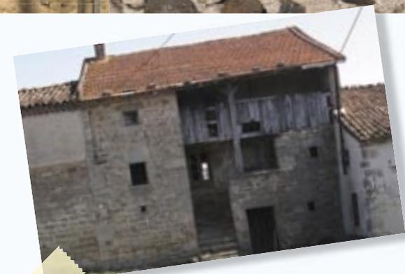
Le bois est présent dans la construction, visible sous forme de bardage sur de petites dépendances agricoles, ou en structure porteuse : pilier des auvents d'estres\* des maisons de vigneron, des auvents de granges... Il est localement utilisé autour de St-Dier pour les encadrements d'ouvertures (lindage\*).
