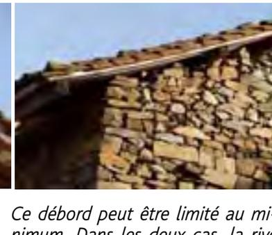
Des tuiles creuses en terre cuite rouge sont utilisées en couverture, maintenues par des pierres sur les parties les plus sensibles au vent : le faîtage et les bords du toit.
