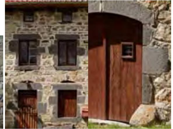
Dans la vallée et sur les premières pentes, les schistes sont assemblés par un discret mortier composé de chaux liée à du sable, ou du « gore » décomposé sur place.
