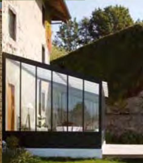
*Une véranda peut constituer un apport de chaleur en mi-saison, mais une protection solaire par des stores, une ventilation par chassis ouvrant permettront de limiter les excès de chaleur en période estivale. (25% de la surface vitrée doit pouvoir s'ouvrir pour rafraichir efficacement) Planter un arbre à l'avant de la véranda peut également être une solution adaptée. Une structure légère favorisera son intégration, ce que permet notamment l'acier.*
