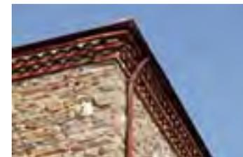
Des appareillages mixtent les deux techniques avec l'alternance de lits de tuiles et de briques.
