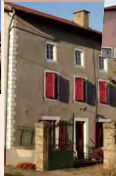
Lorsque la façade est enduite, la génoise est intégrée au bandeau de toit.
