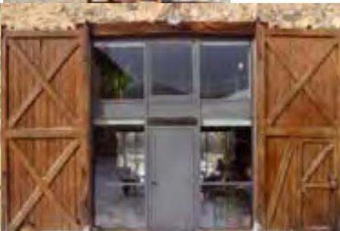
Le choix de matériaux plus contemporains est bien sûr possible. La teinte est importante et l'on évitera les couleurs claires. Les menuiseries en aluminium laqué gris sont ici bien adaptées, et les portes de grange permettent de sécuriser l'ouverture. L'épaisseur du plancher de l'étage est dissimulée en façade par la menuiserie.
