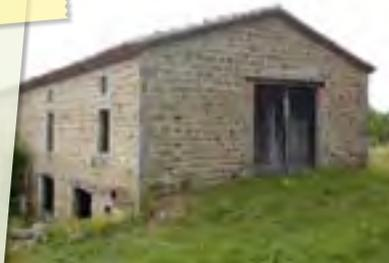
**Adapter la construction à la pente en limitant le terrassement permet une meilleure insertion dans le site et préserve l'aspect naturel du terrain.**
