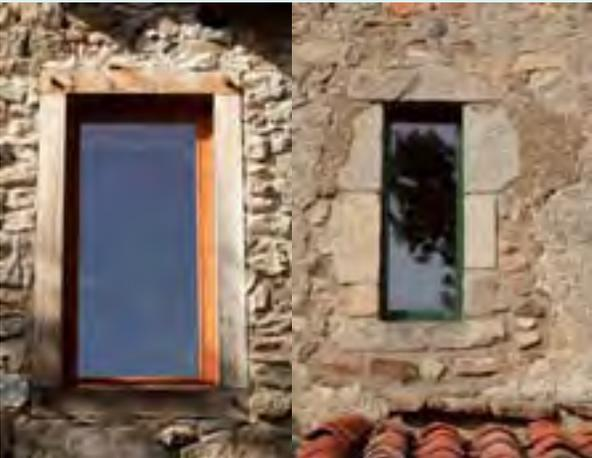
*L'encadrement est affirmé visuellement par un linteau traditionnel. La maçonnerie de pierre peut être conservée en l'état.*
