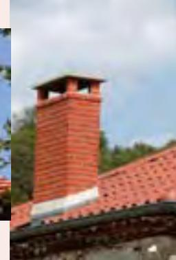
Dans le cas d'un toit à très faible pente (inférieure à 25%) la pose d'une sous toiture de type plaques ondulées, assurant l'étanchéité sera indispensable pour une couverture en tuiles canal. Ce dispositif permet d'utiliser des tuiles canal de récupération.
