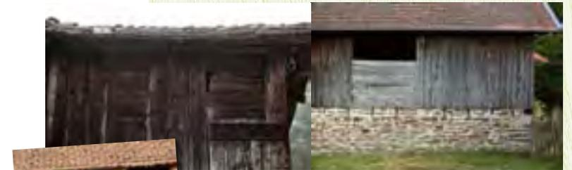
La présence du bois en bardage ou en claire-voie en étage supérieur permettant la ventilation et le séchage caractérise les féculeries et moulins à papier.
