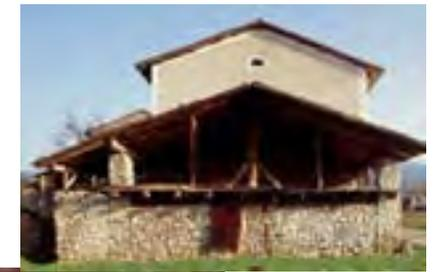
Les piles de pierre caractéristiques de l'architecture du Livradois sont utilisées pour porter le toit de ces hangars.
