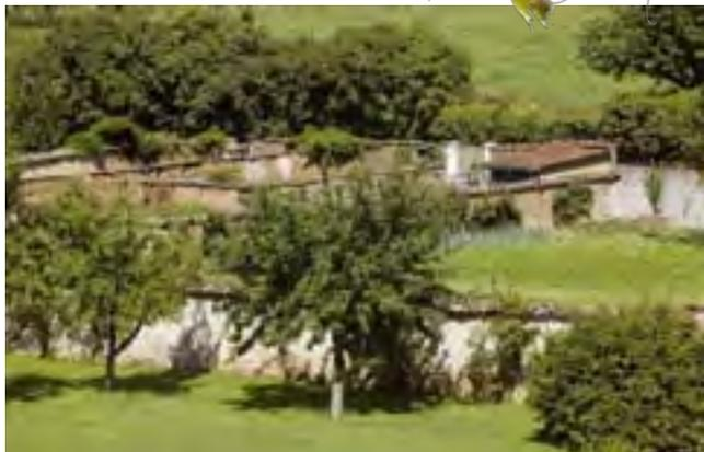
Le faitage des murs de clôture est traditionnellement protégé par un rang simple ou double de tuiles creuses.
