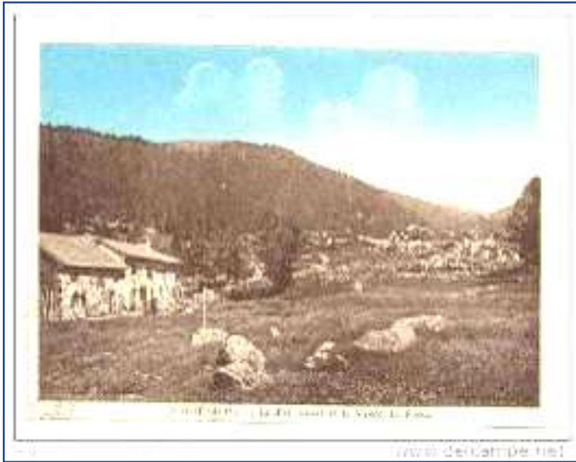
5 : Jasseries à l'entrée du site.
