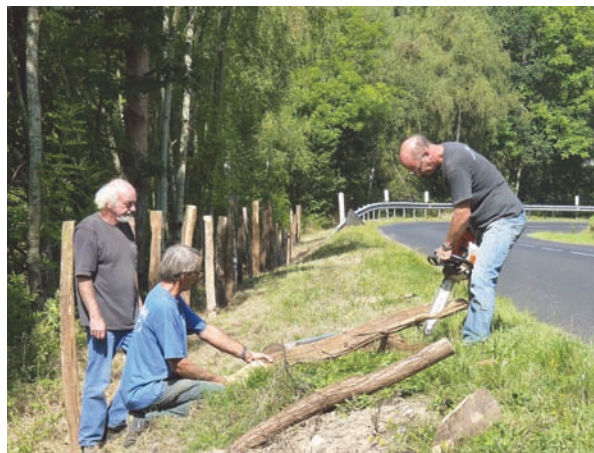
Remise en état de la clôture à Auzelles
