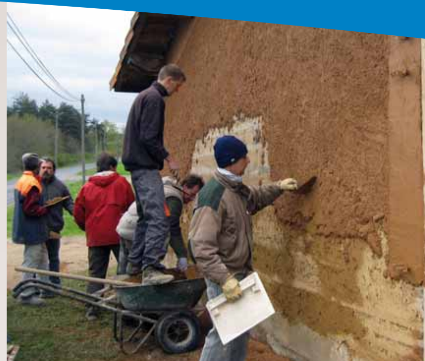
▲ Application d'un enduit de terre stabilisée à la chaux à Sermentizon.
