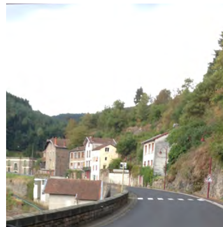
[Photo ci-dessus] D906 dans la traversée d'Olliegues.
