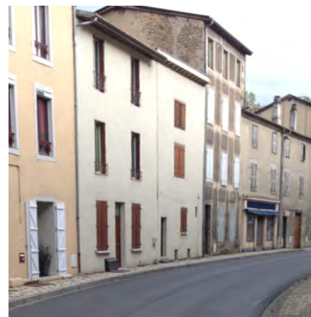
[Photo ci-dessus] Bâties vacants dans la traversée d'Olliegues.
