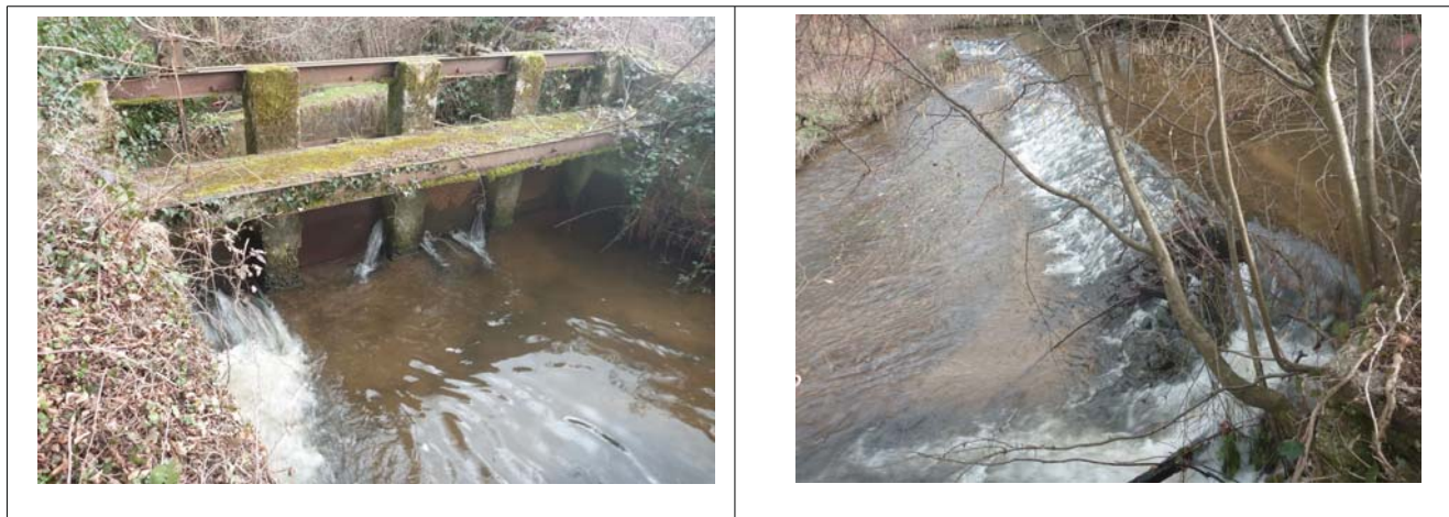
Illustration 22: Seuil sur la Durolle et prise d'eau alimentant l'entreprise Preciforge et un agriculteur
