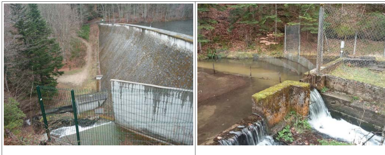
Illustration 18 : Barrage de la Muratte et prise d'eau sur la Credogne (Ville de Thiers - Commune de St Victor Montvianeix)
