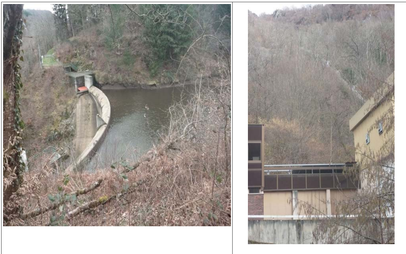
Illustration 27 : Le barrage de Membrun et la conduite forcée au point aval
