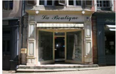
Local RdC relié à une habitation (habitant propriétaire) aux étages, espace "dormant"
