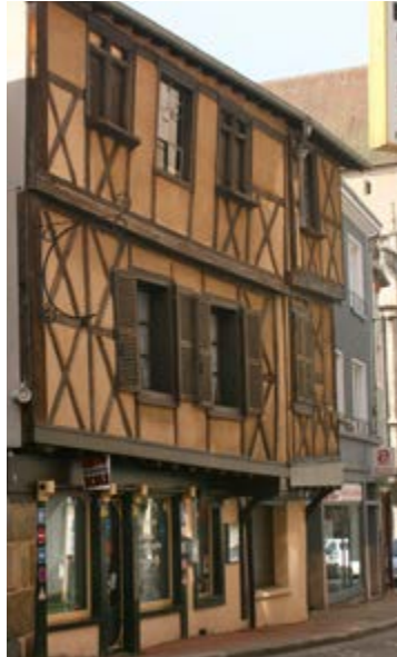
RdC à gauche de l'auto-école, et étages vacants et nécessitant rénovations
