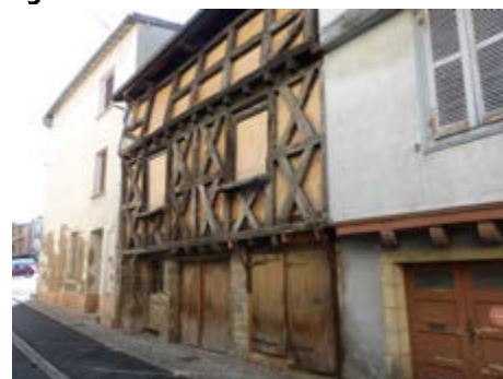
Bâti vacant en état de ruine
