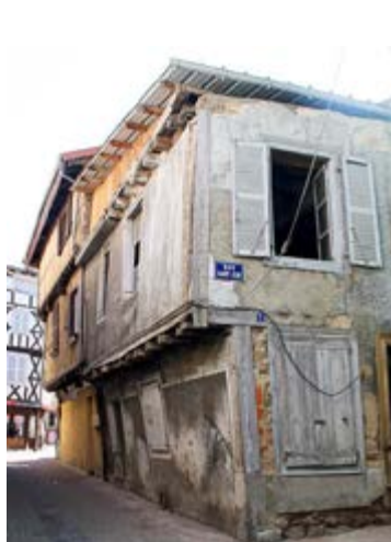
Bâti vacant en état de ruine
