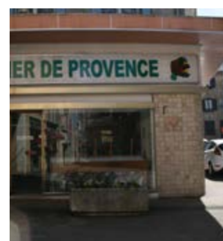
Local en RdC ancienne épicerie mis en location, grandes surfaces
