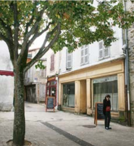
Bâti vacant "le Progrès" nécessitant rénovations
