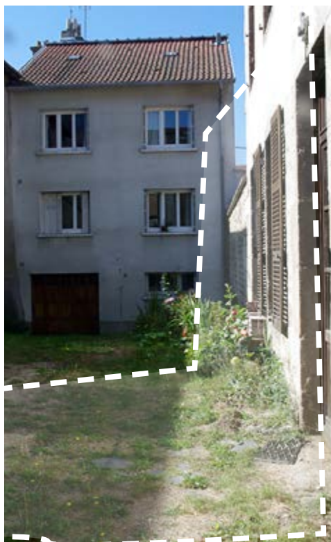
RdC vacant nécessitant rénovation (à droite) donnant sur une cour non ou peu utilisée
