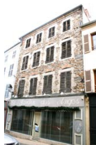
Bâti vacant en état de ruine
