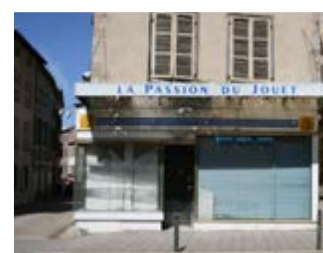
RdC dormant en cours de rénovation
