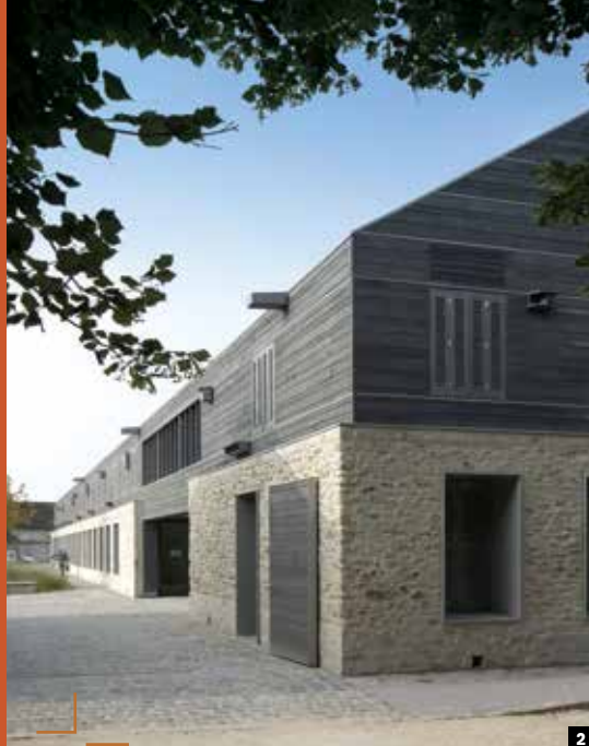
Maison du Parc naturel régional du Gâtinais français, Milly-la-Forêt (91). Ossature bois avec un parement en grès de Fontainebleau.
