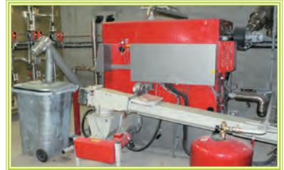
Chaudière bois de la collectivité
