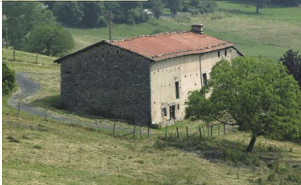
Des tuiles creuses en terre cuite rouge sont utilisées en couverture, maintenues par des pierres sur les ouvrages plus sensibles au vent : le faitage, les bords de toit.
