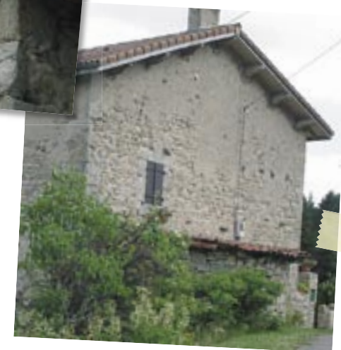
Les murs pignons peuvent être également protégés par un débord de toit portée par des pannes.
