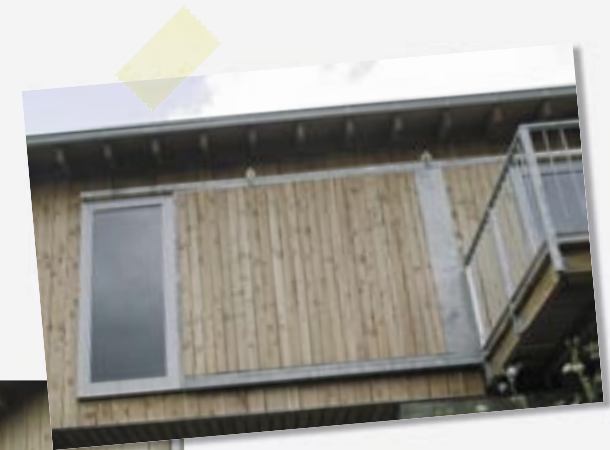
Les volets coulissants sur un rail associent bois et fer pour une mise en œuvre simple et économe inspirée des ateliers de coutellerie de la région.
