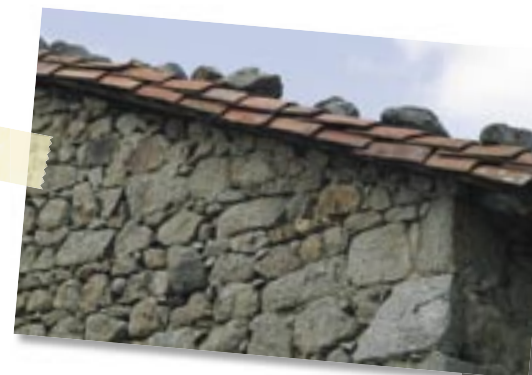
Les murs pignons peuvent être également protégés par un débord de toit portée par des pannes.
