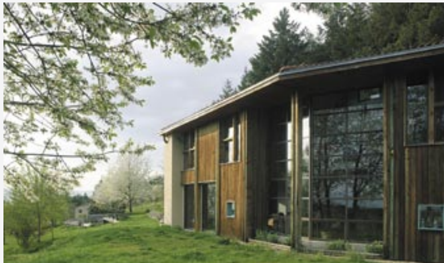
La façade sud de la maison est réalisée en bois et verre, enchassée entre deux murs pignons en maçonnerie traditionnelle.
