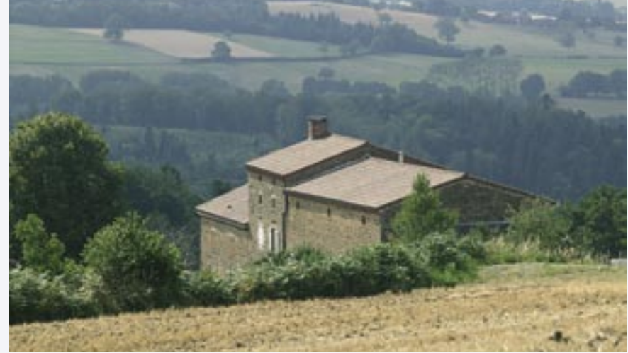
La pente protège largement cette ferme dont toutes les ouvertures sont orientées au sud.
