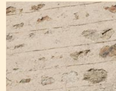
Les lits de pierre étaient parfois soulignés d'un trait horizontal, réalisé dans le mortier frais avec le fer de la truelle, appelé layage.
