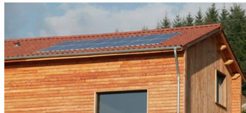
Le choix du solaire en amont du projet permet une meilleure intégration des capteurs.
