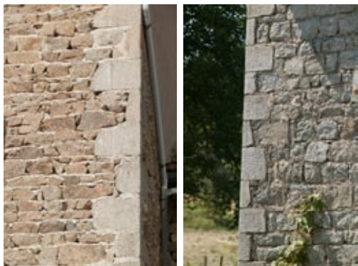
Les constructions sont majoritairement bâties en pierre, assemblées par un discret mortier composé de chaux liée à du sable, ou à du « gore » décomposé sur place.
