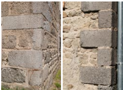
Les chaînages d'angle , les encadrements d'ouverture : linteaux , jambages ... sont réalisés avec des matériaux résistants et faciles à appareiller : granit, parpaings de mâchefer, brique.
