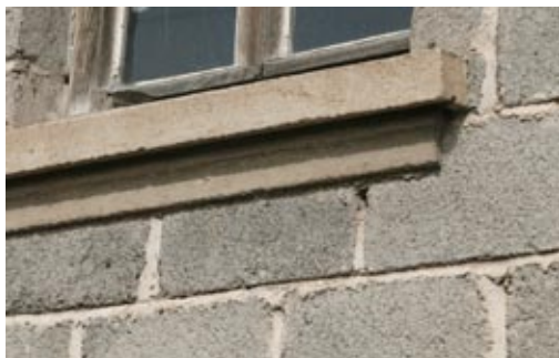
On trouve dans la vallée quelques annexes édifiées en parpaings de mâchefer .
