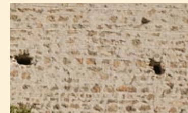
Dans les hameaux, les constructions isolées étaient simplement jointoyées.
