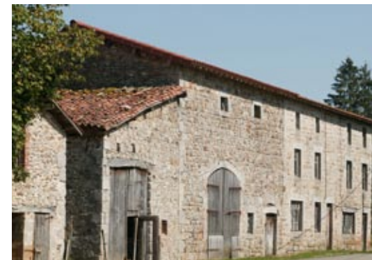
Dans les hameaux, les constructions isolées étaient simplement jointoyées.
