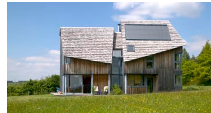
La maison est intégralement réalisée en mélèze qui grisera progressivement avec le toit. De conception bioclimatique, elle est chauffée par un plancher solaire direct, complété par un poêle à bois.
