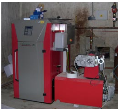
Exemple de chaudière bois
