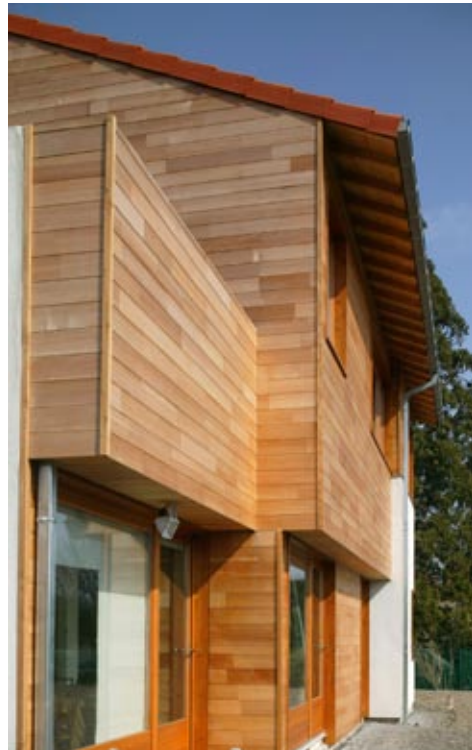
Maison en bois massif préfabriquée en atelier
