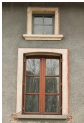
Encadrements de fenêtre.
