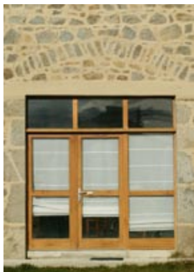
Trois trames différentes pour le traitement de ces anciennes portes de grange : trois propositions respectueuses et novatrices où l'utilisation du bois est privilégiée.
