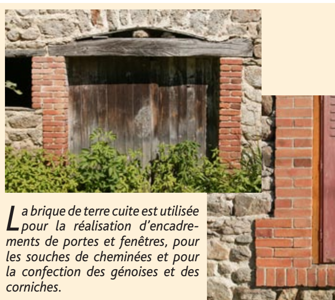
Les constructions sont majoritairement bâties en pierre, assemblées par un discret mortier composé de chaux liée à du sable, ou à du « gore » décomposé sur place.
