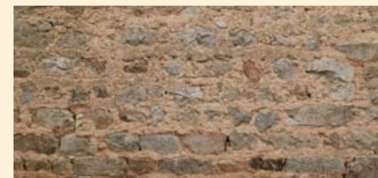
Les jointoyements sont réalisés à « fleur de pierre » afin d'étanchéifier au maximum les interstices.
