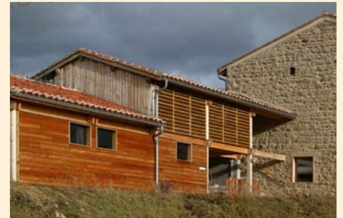
Cette extension est réalisée en bois, dans le prolongement du logement existant.
