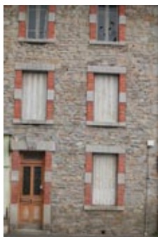
Façade jamais enduite. Les encadrements d'ouvertures en saillie attestent de la volonté d'enduire ultérieurement.
