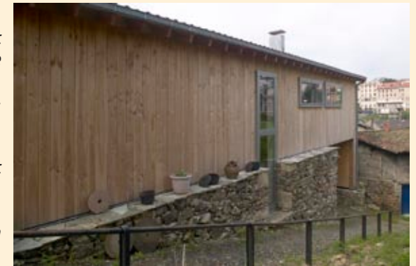
La structure bois vient se poser sur le mur de clôture reconstitué.
