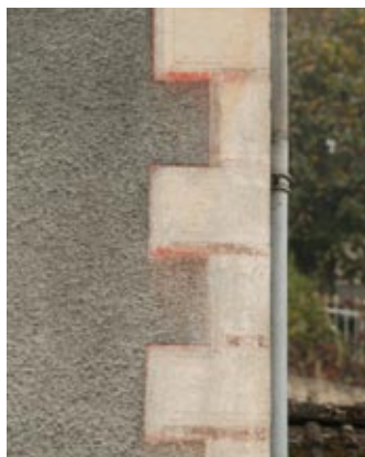
Chaînage d'angle harpé.
