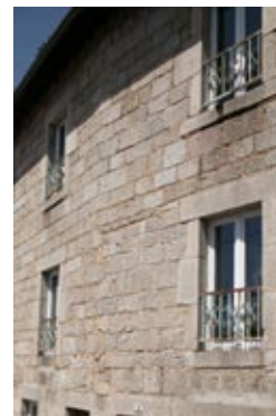
Un des rares exemples de maçonnerie de pierres taillées destinées à rester apparentes.
