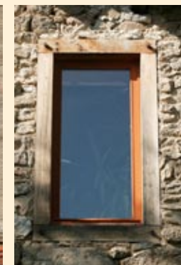
Sur les secteurs de montagne, l'utilisation d'encadrement bois conserve la maçonnerie en l'état.
