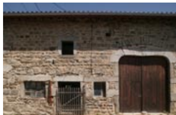
La porte d'étable et la porte de grange sont les principales ouvertures des dépendances agricoles. Le linteau peut être droit ou cintré.
