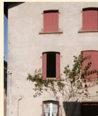
Les enduits talochés ou frisés fin sont les plus répandus.
