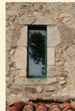
L'utilisation de pierres locales et un travail soigné de maçonnerie permettent de créer une nouvelle fenêtre.
