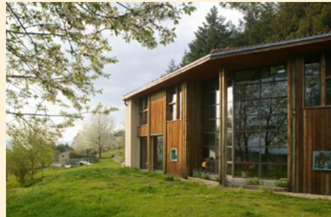
La façade de la maison, exposée au sud, est réalisée en ossature et bardage bois, les murs pignons et la façade nord sont en maçonnerie traditionnelle.
