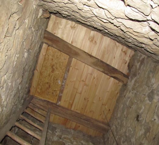
Eglise de Sainte Marguerite et son plancher rénové dans le clocher
