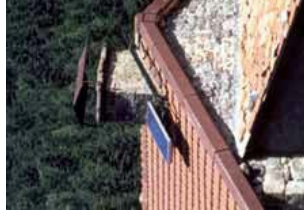
Petit équipement photovoltaïque sur habitat isolé
