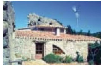
Petit aérogénérateur équipant une maison ancienne
