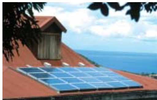
Maison isolée en Guadeloupe équipée de modules photovoltaïques
